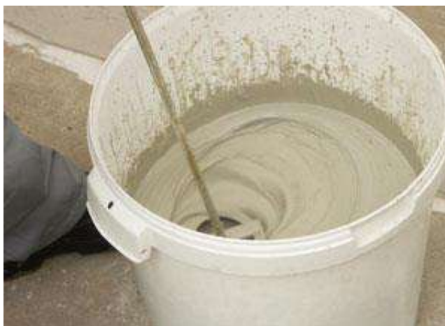
Рисунок 7 – Приготовление состава из сухой смеси и воды
