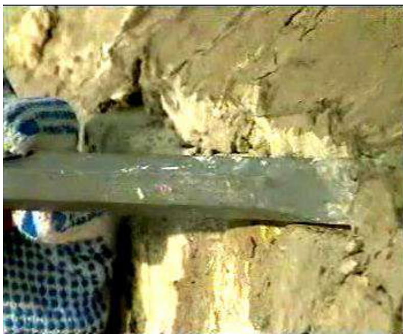
Рисунок 4 – Удаление штукатурного слоя зубилом
