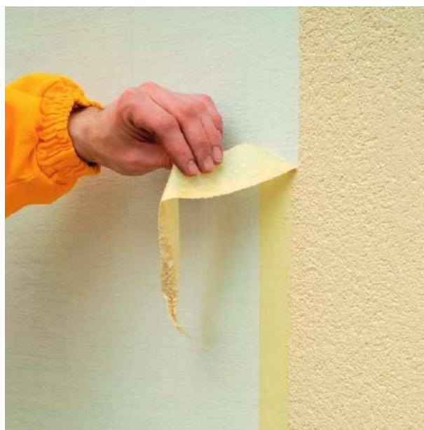
Рисунок 11 – Наклейка и снятие самоклеящейся ленты
