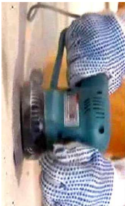
Рисунок 5 – Удаление пятен от битума, красок шлифовальной машиной
