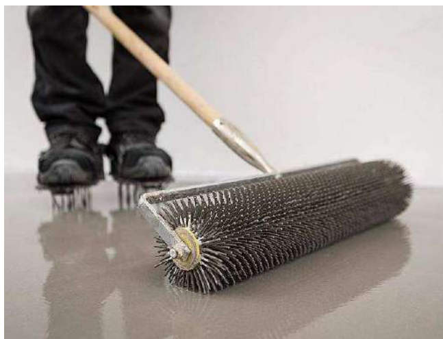
Рисунок 24 – Раскатывание уложенной смеси игольчатым валиком
