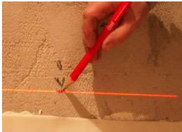
Рисунок 9 – Вынос на стену «нулевого» уровня
