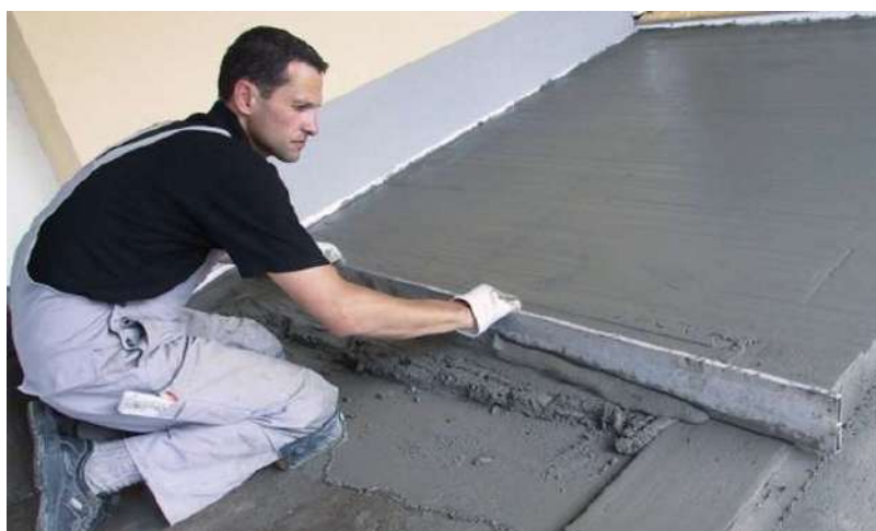
Рисунок 20 – Разравнивание смеси правилом
