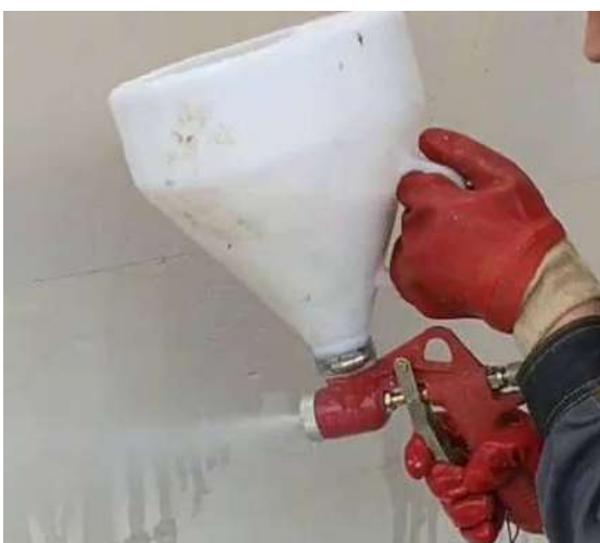
Рисунок 13 – Ручное нанесение грунта
