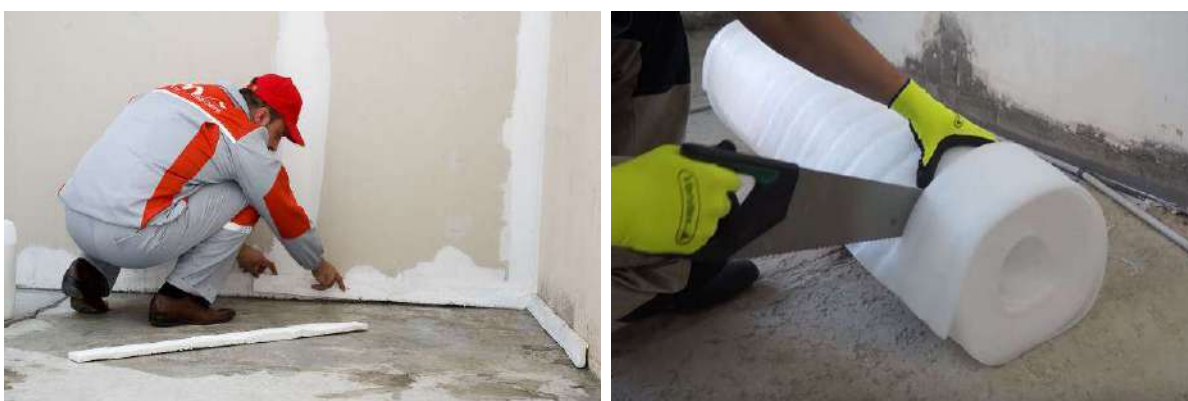
Рисунок 6 – Устройство деформационного шва
