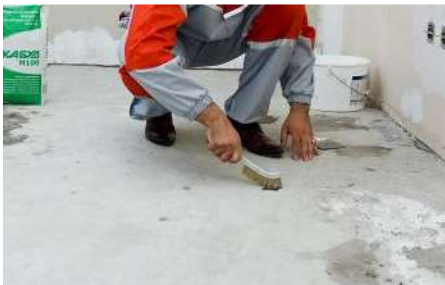
Рисунок 2 – Удаление непрочного слоя металлической щеткой
