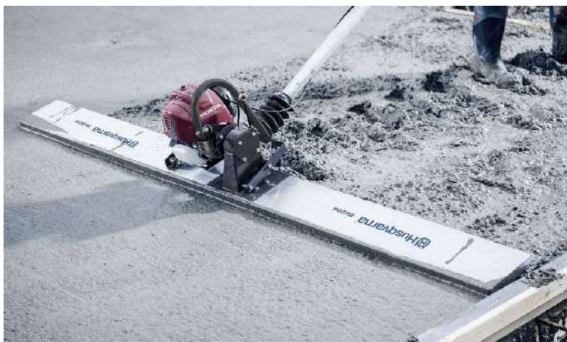
Рисунок 21 – Разравнивание поверхности виброрейкой
