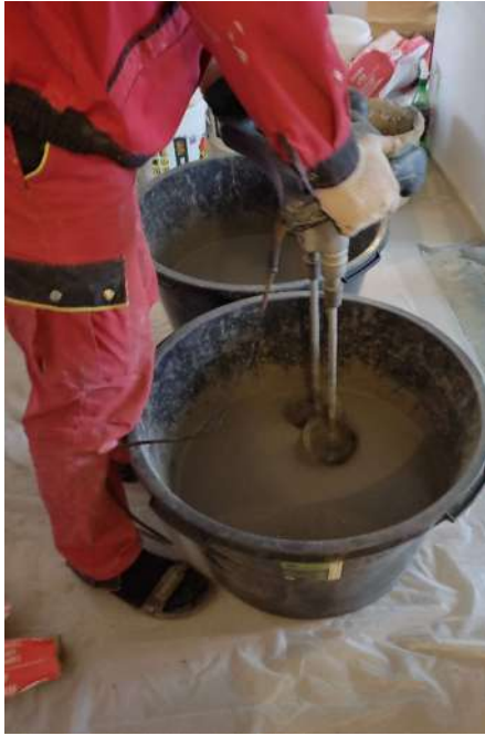
Рисунок 18 – Перемешивание смеси ручным способом
