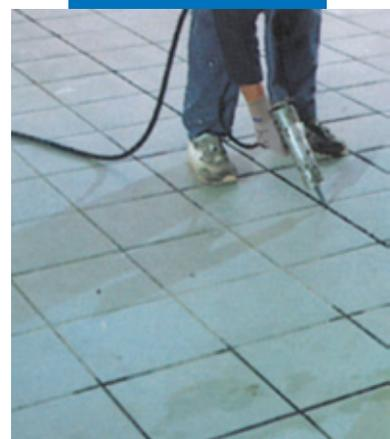
Герметизация швов в плитке посредством Mapesil AC
