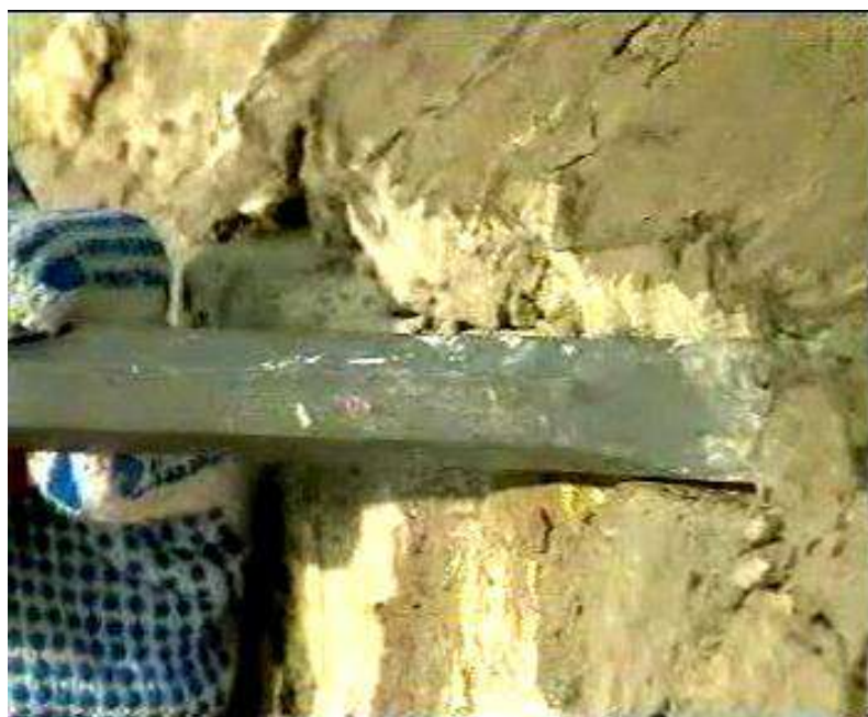
Рисунок 4 – Удаление штукатурного слоя зубилом
