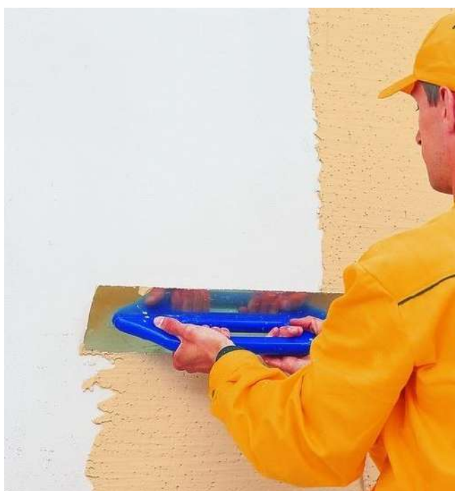
Рисунок 9 – Нанесение штукатурки металлической теркой
