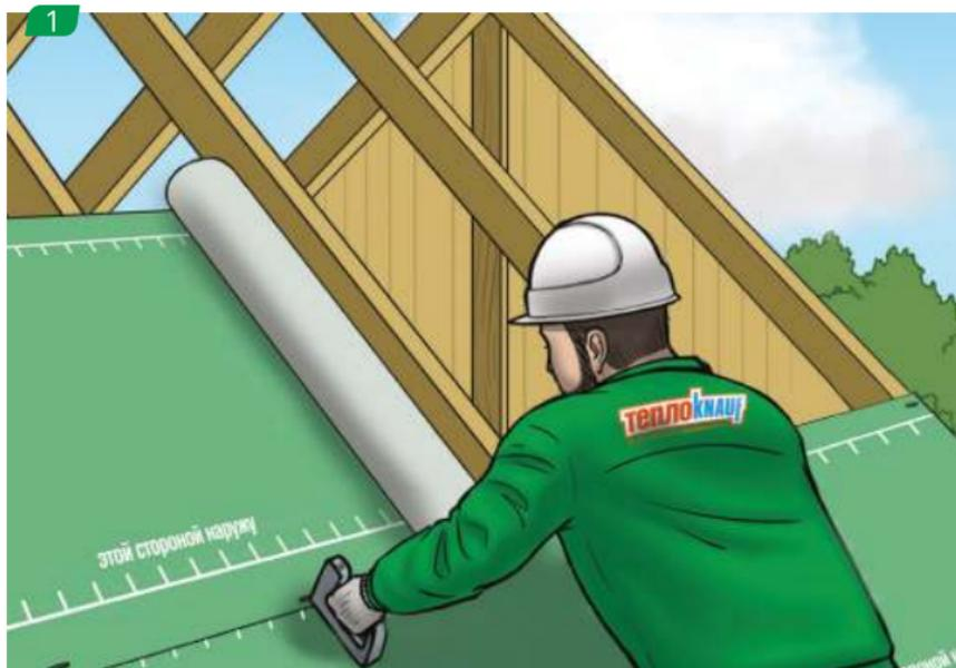
Раскатываем мембрану горизонтально вдоль нижней части стропил и фиксируем к стропилам степлером.
