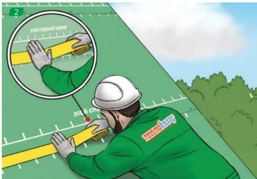
Каждый последующий слой — выше предыдущего, нахлест в 10-15 см. В районе конька — также внахлест. Стыки и места крепления степлером проклеиваем лентой для проклейки швов.
