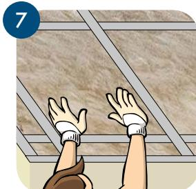
Устанавливаем АкустиKNAUF в каркас. Толщина материала определяется высотой конструкции.
