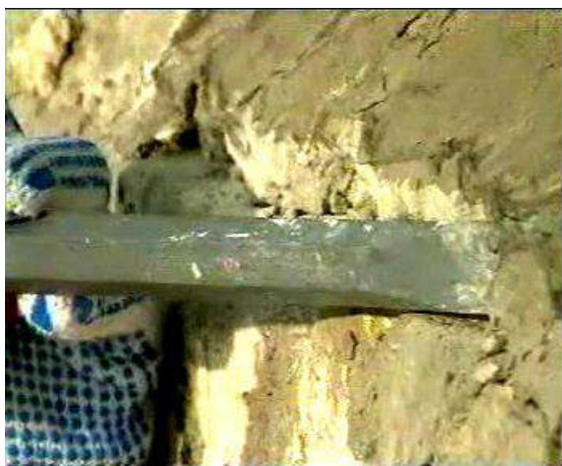
Рисунок 4 – Удаление штукатурного слоя зубилом
