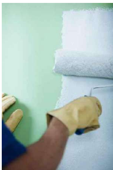
а - при помощи валика; б - при помощи краскопульта
