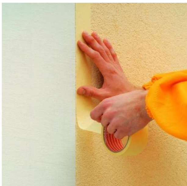
Рисунок 11 – Наклейка и снятие самоклеящейся ленты
