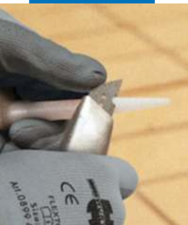
Отрезание носика в соответствии с размером швов
