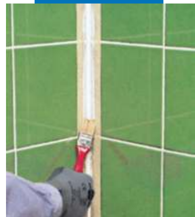
Заглаживание шва кисточкой, смоченной в мыльной воде
