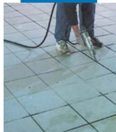
Герметизация швов в плитке посредством Mapesil AC
