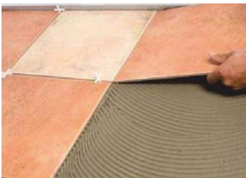
Рисунок 2. Укладка плитки на клеевой состав.
