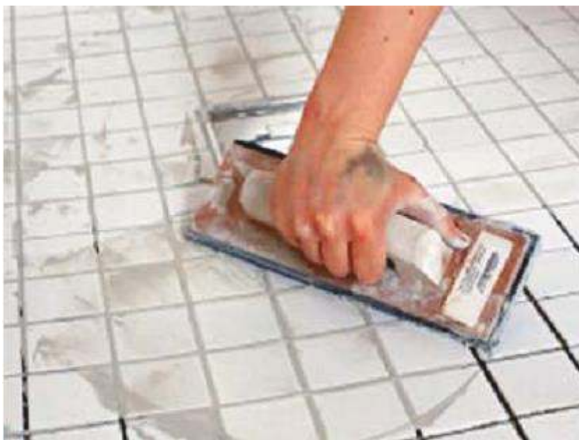
Рисунок 3. Заполнение швов.
