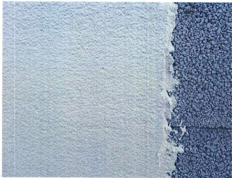
Рисунок 1 – Общий вид оштукатуренного участка стены с помощью теплоизоляционной штукатурки «ilmax thermo теплая стена 3D»
