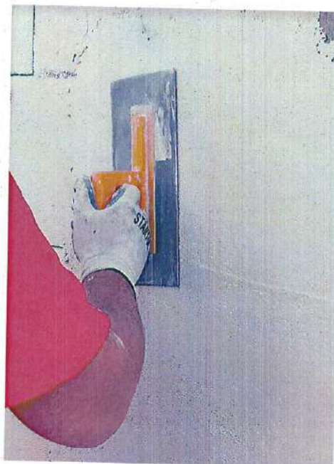
Рисунок 25 – Формирование фактуры поверхности с помощью пластиковой терки
