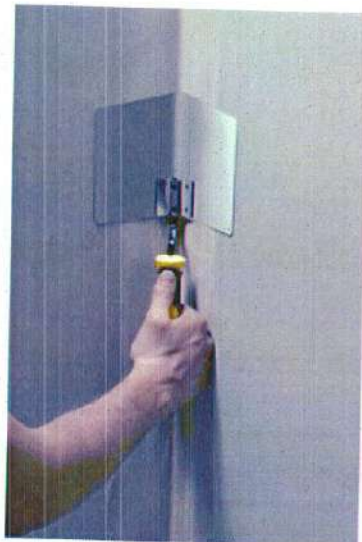
Рисунок 23 – Разравнивание углов при помощи угловых шпателей
