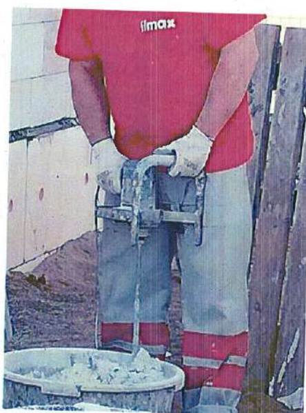
Рисунок 20 – Приготовление штукатурной смеси с помощью строительного миксера
