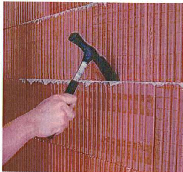
Рисунок 15 – Срубка наплывов раствора
