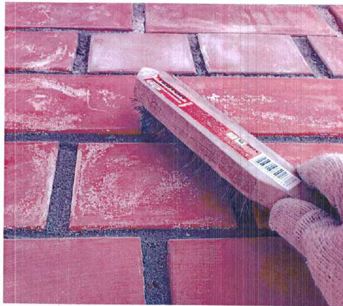
Рисунок 14 – Очистка поверхности
