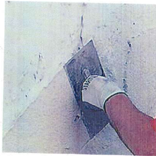
Рисунок 22 – Нанесение штукатурной смеси с помощью металлической терки
