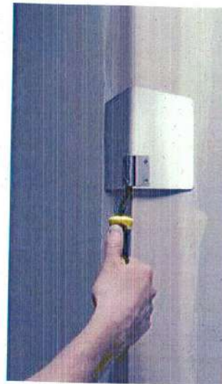
Рисунок 23 – Разравнивание углов при помощи угловых шпателей
