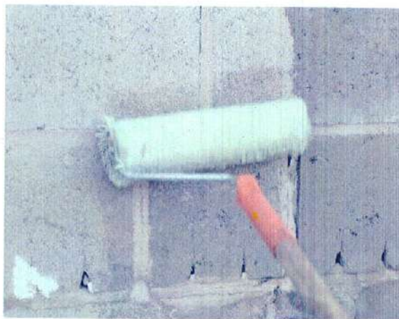
Рисунок 16 – Грунтование поверхности
