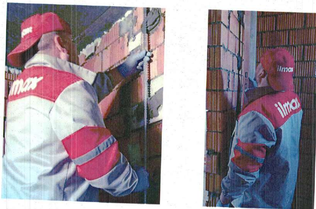
Рисунок 19 – Установка маяков на штукатурную смесь
