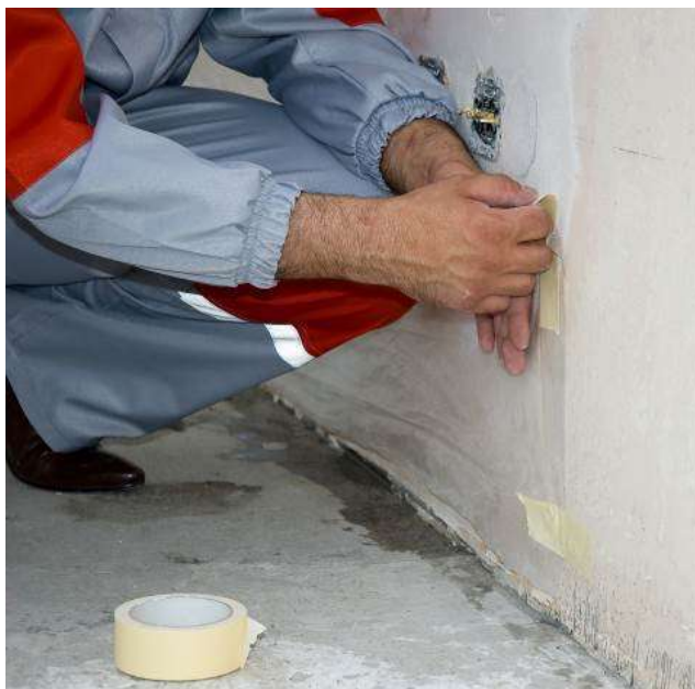
Рисунок 7 – Защита стен полиэтиленовой пленкой
