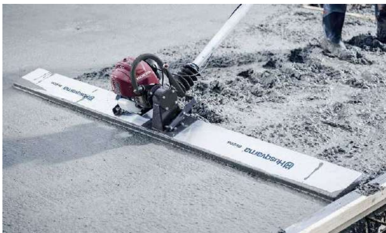
Рисунок 21 – Разравнивание поверхности виброрейкой
