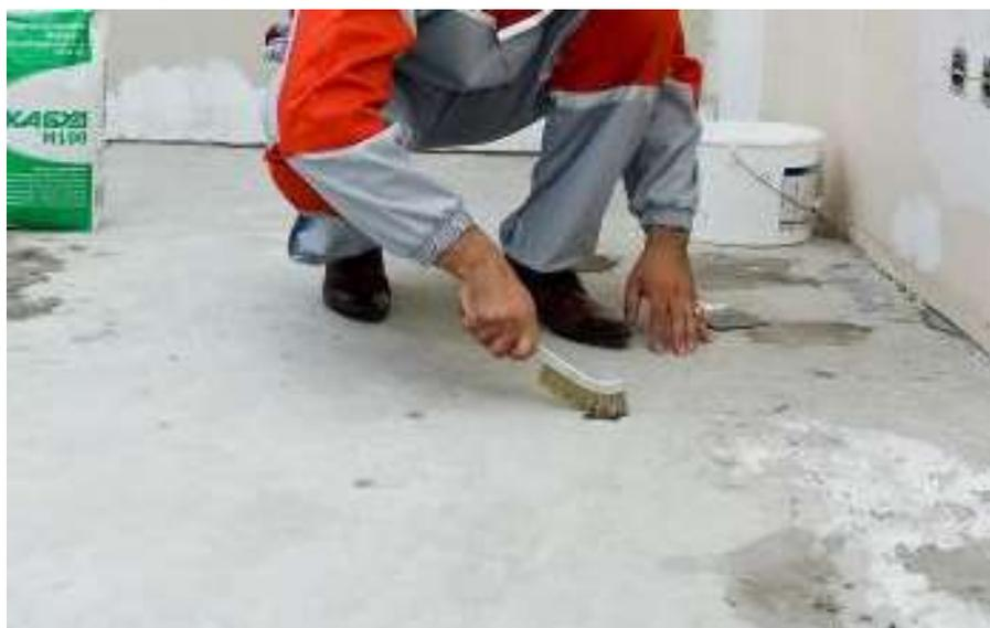
**Рисунок 2** – Удаление непрочного слоя металлической щеткой
