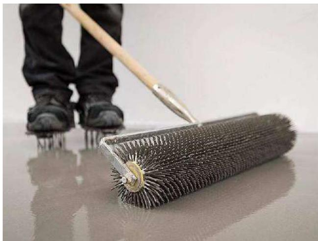
**Рисунок 24** – Раскатывание уложенной смеси игольчатым валиком
