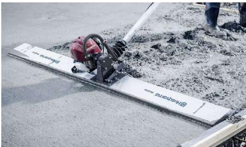
**Рисунок 21** – Разравнивание поверхности виброрейкой
