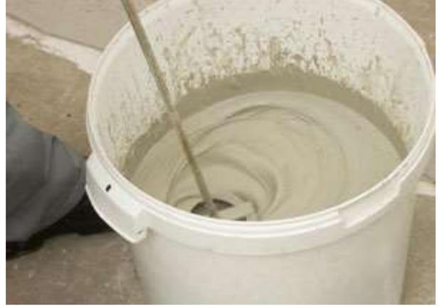
**Рисунок 18** – Перемешивание смеси ручным способом
