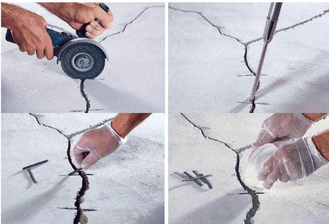
**Рисунок 3 – Ремонт трещин**
