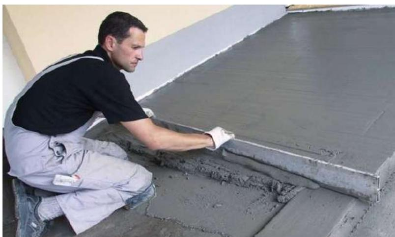
**Рисунок 20** – Разравнивание смеси правилом
