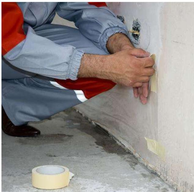
**Рисунок 7 – Защита стен полиэтиленовой пленкой**
