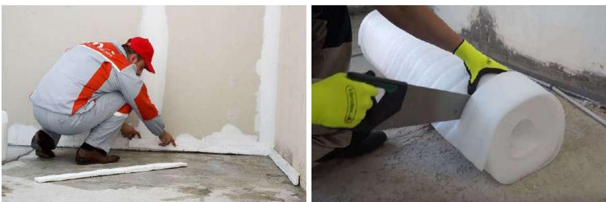
Рисунок 6 – Устройство деформационного шва
