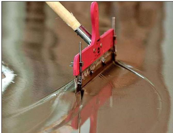
**Рисунок 23** – Распределение смеси по основанию с использованием ракеля
