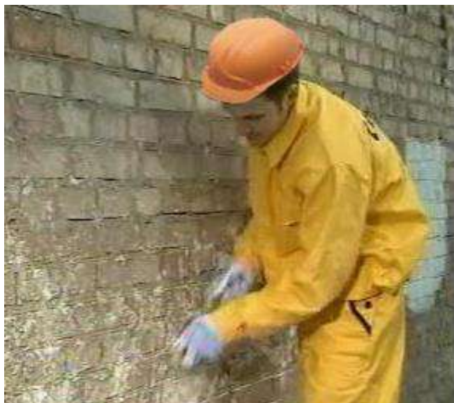
Рисунок 3 – Удаление отделочного слоя щеткой
