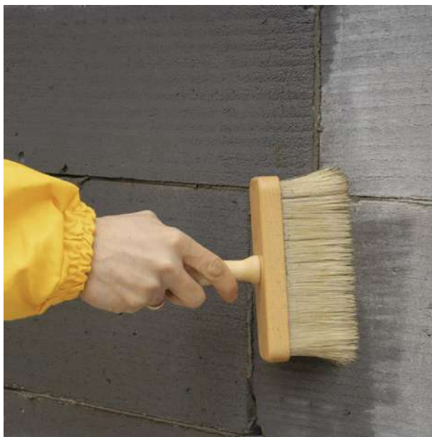
Рисунок 8 – Грунтование поверхности основания кистью
