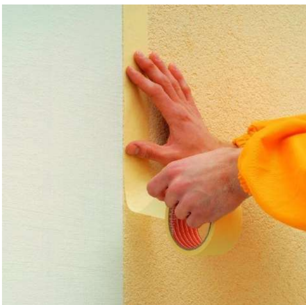
Рисунок 11 – Наклейка и снятие самоклеящейся ленты
